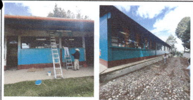
Foto 5: PINTURA EN MUROS EXTERIORES E INTERIORES. Por deterioro y cambios climaticos
