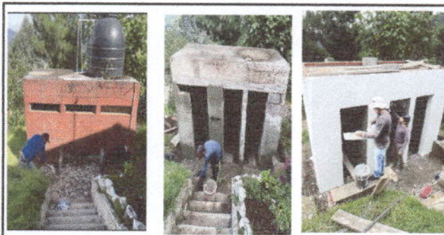
Foto 6: SERVICIOS SANITARIOS , la puerta de los sanitarios estan en la orilla del borde,y estan en mal estado por lo que es indispensable cambiarlos de posicion,y realizar una remodelacion completa
