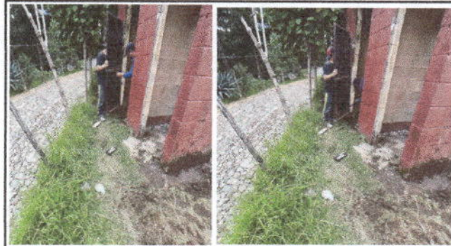
Foto 2: Sustitución de puerta en servicios sanitarios por deterioro debido a los cambios climaticos.
