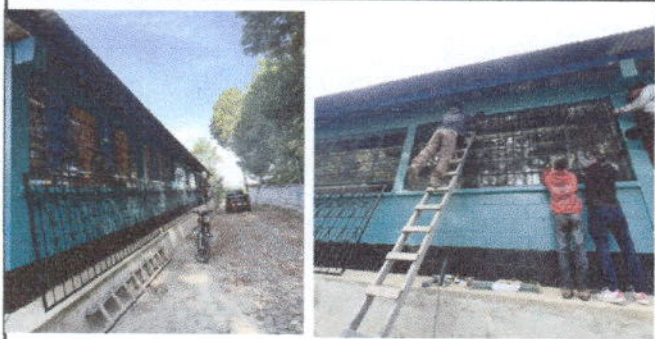
Foto 3: VENTANAS colocacion de balcones de metal para proteccion de ventanales y seguridad de las aulas y cocina, son 3 aulas con 4 ventanales cada una y 2 vetanas de la cocina haciendo un total de 14
